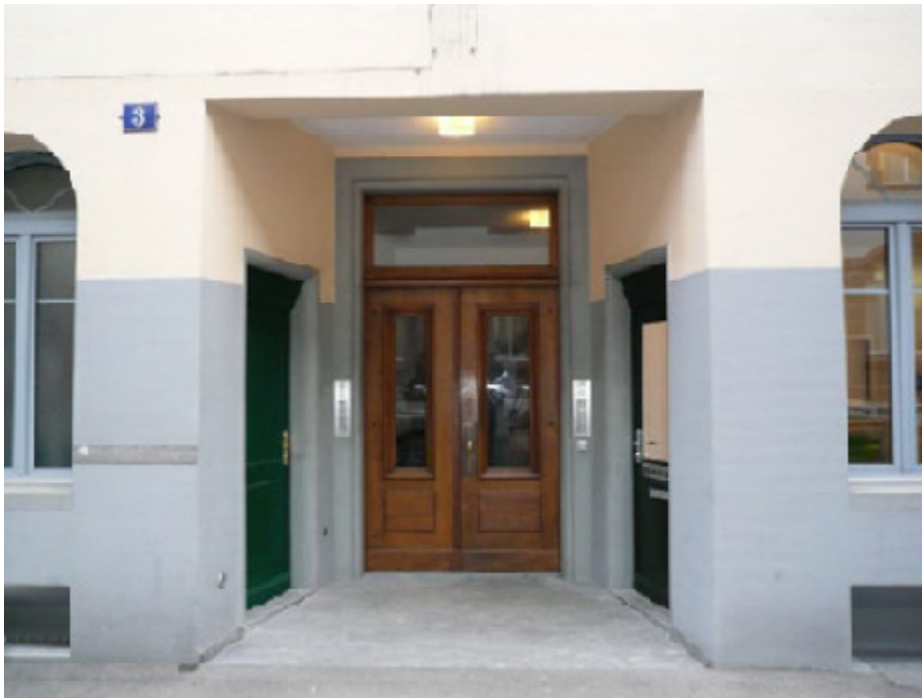
Einwärtiger Türraum. Jenatschstr. 3, 8002 Zürich (1930)
